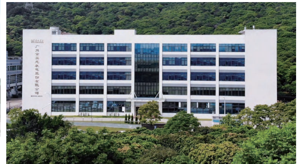
田园厂 Tianyuan Factory
