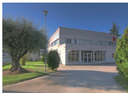
西班牙厂 Spanish Factory
