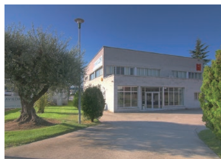
西班牙厂 Spanish Factory
