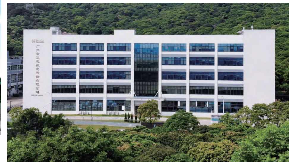
田园厂 Tianyuan Factory
