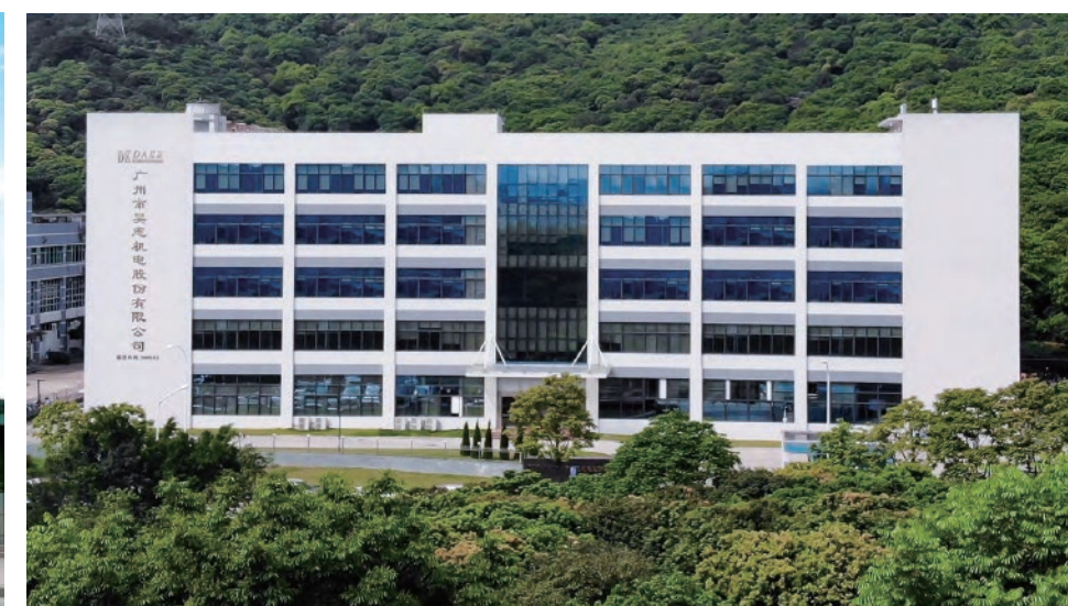
田园厂 Tianyuan Factory
