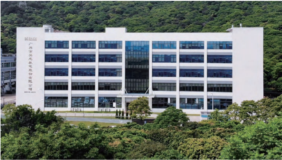
田园厂 Tianyuan Factory
