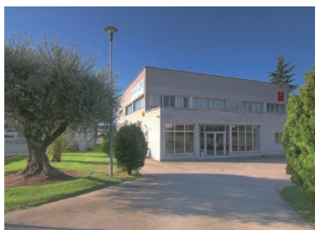
西班牙厂 Spanish Factory
