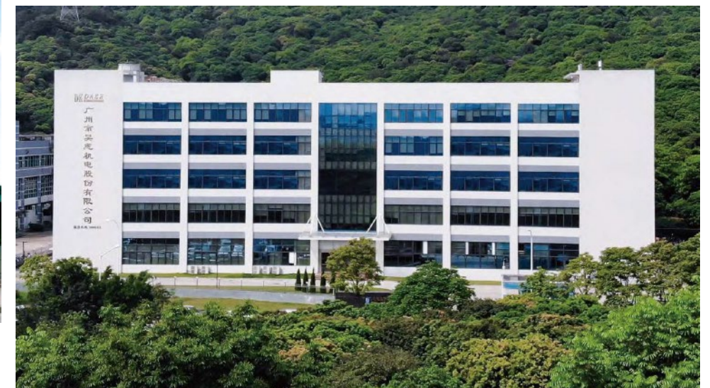
田园厂 Tianyuan Factory
