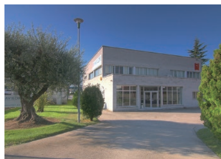
西班牙厂 Spanish Factory
