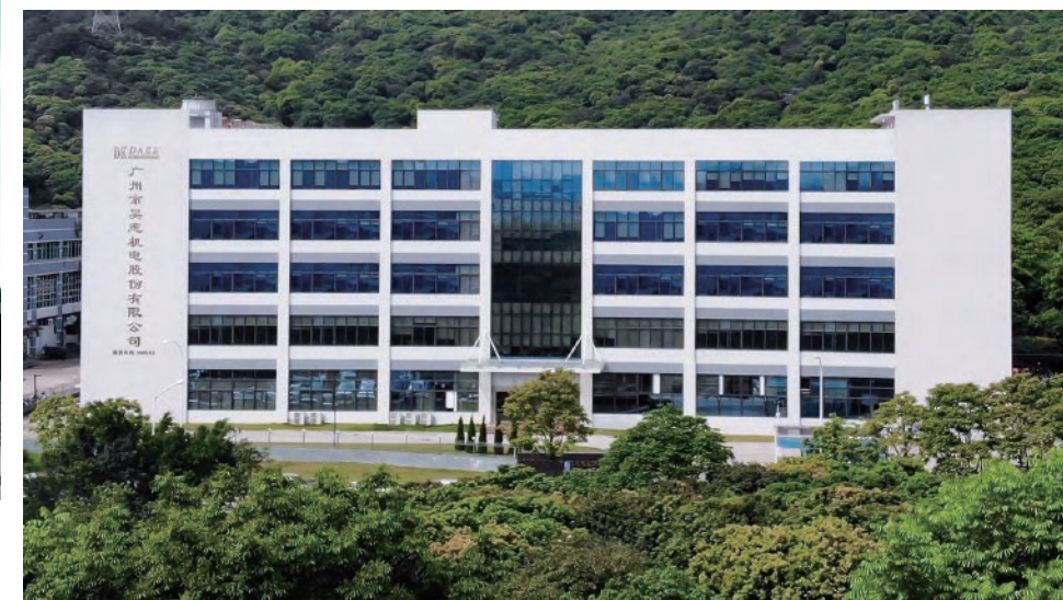
田园厂 Tianyuan Factory
