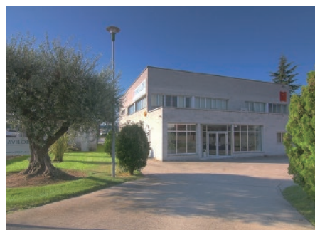
西班牙厂 Spanish Factory
