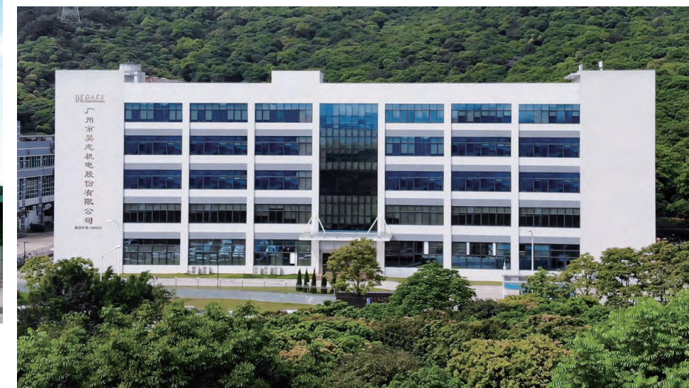
田园厂 Tianyuan Factory
